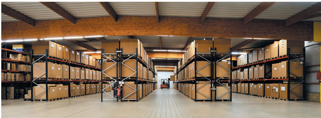
Hall de stockage paletier
