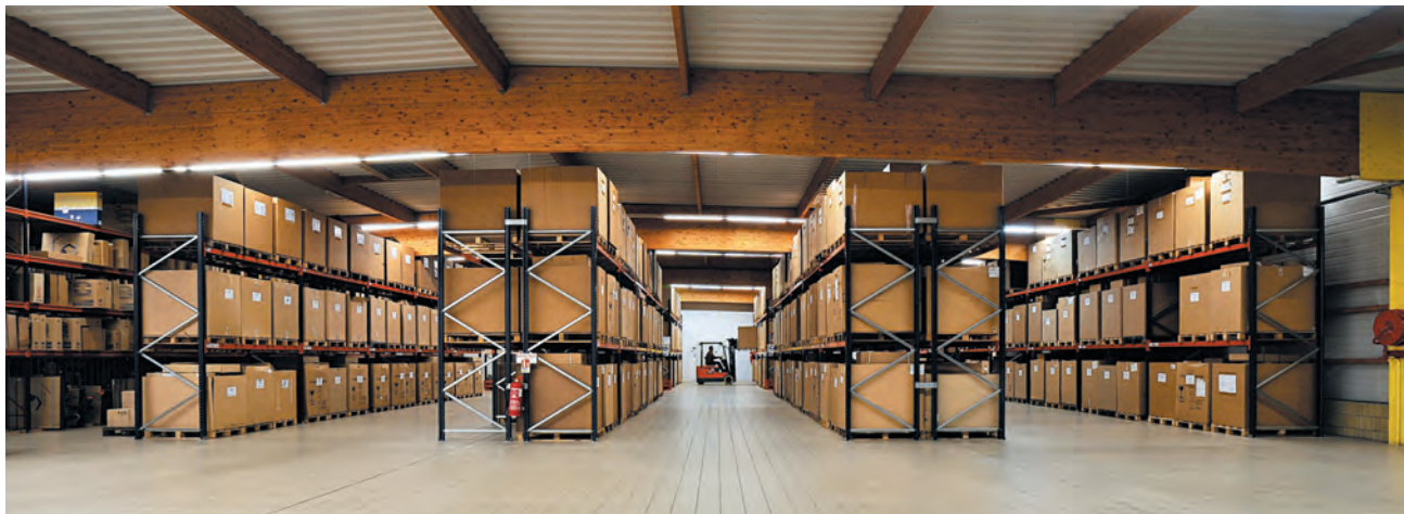
Hall de stockage paletier
